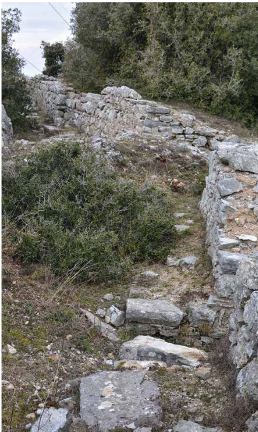
6. Π.Ε. Καβάλας. Θέση 5. Άποψη του προμαχώνα/ χαρακώματος: λιθοδομές
